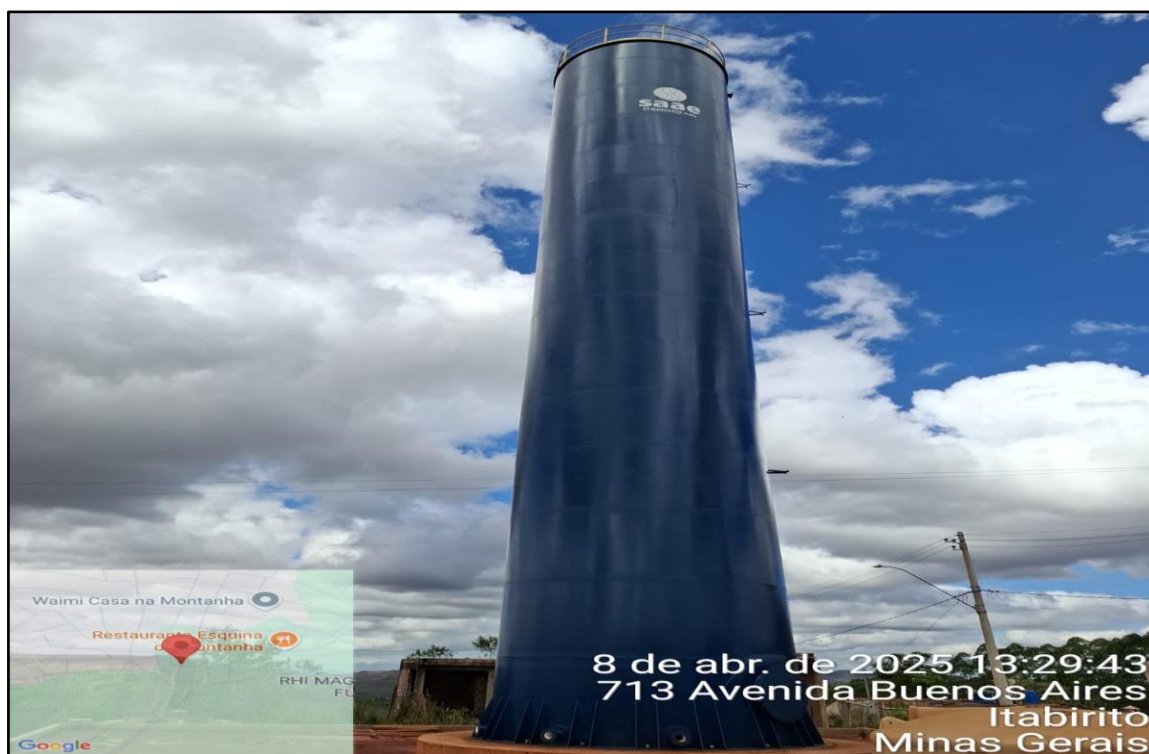
Reservatório metálico do Balneário Água Limpa
