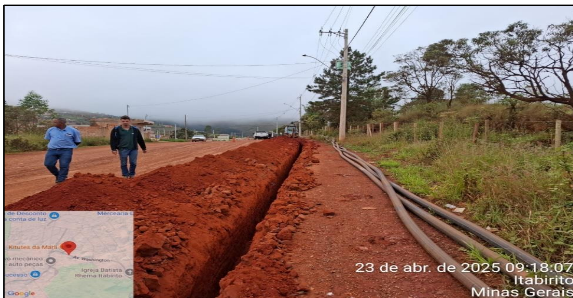
Construção da rede de alimentação do reservatório Água Limpa
